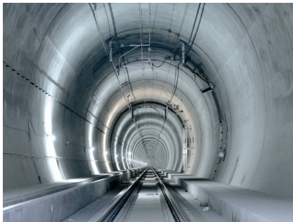
Tunnelquerschnitt (Foto TU ABL)
