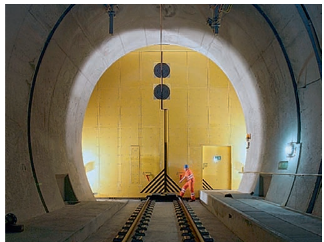
Bild 2: Bahntunnelort Oströhre bei km 36,245.
